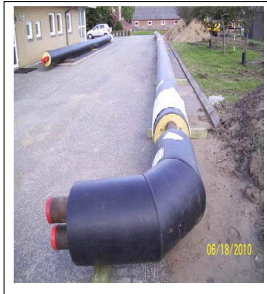
12 meter lange rør svejses sammen
